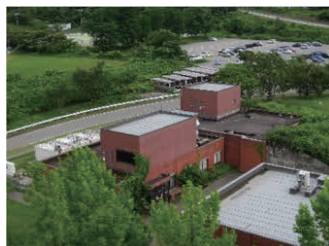
施設の全景 (背後に白い排水槽が見える茶色の建物)
